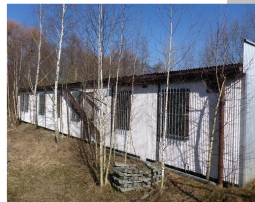
Ausgangszustand Baracke (Febr. 2015)
