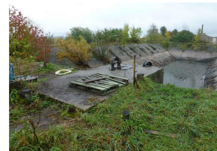
Ausgangszustand Güllebecken (Okt. 2015)
