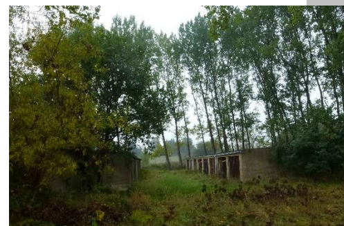
Ausgangszustand Garagenkomplex (Okt. 2015)
