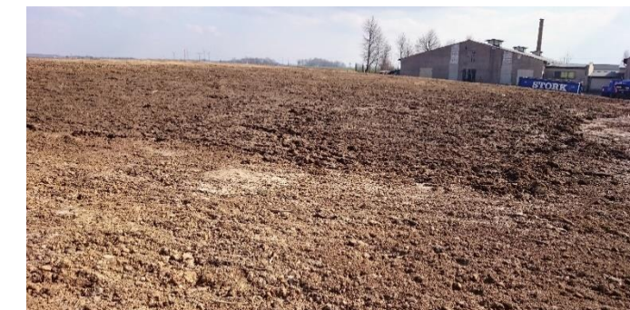
Nach Abbruch- und Entsiegelungsarbeiten / Verfüllung (März 2016)
